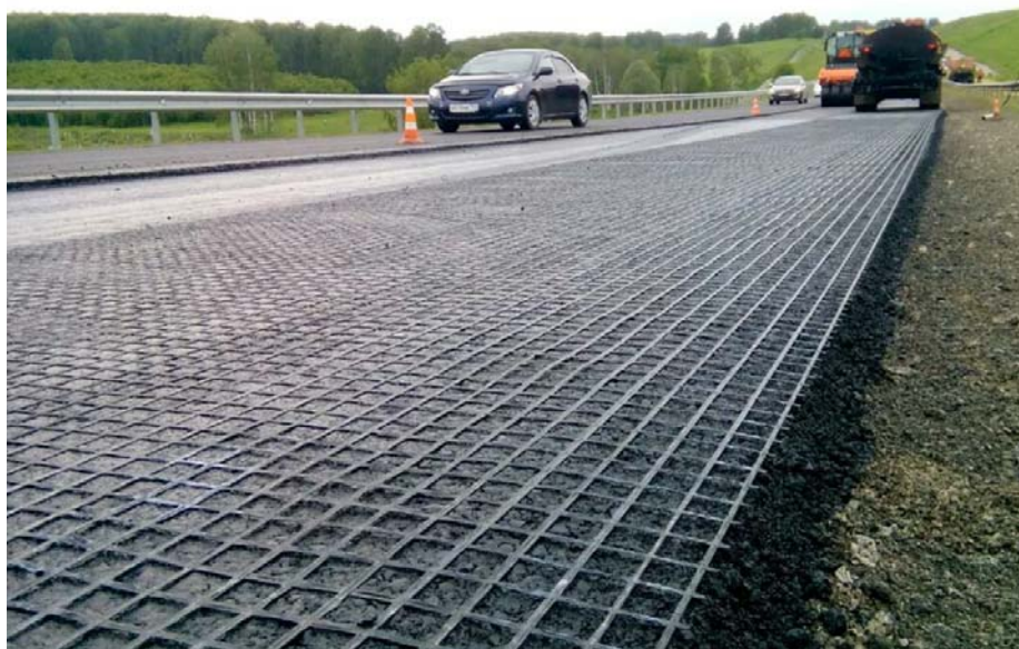
Рис. 3. Армирование дорожного полотна полиэфирной геосеткой
