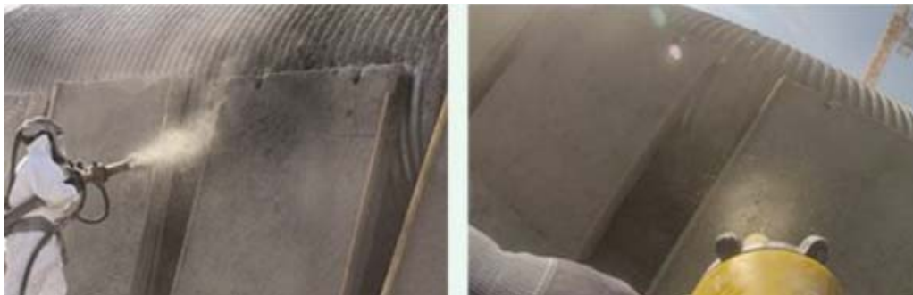
Рис. 4. Применение СПБФ при ремонте водопропускных труб
