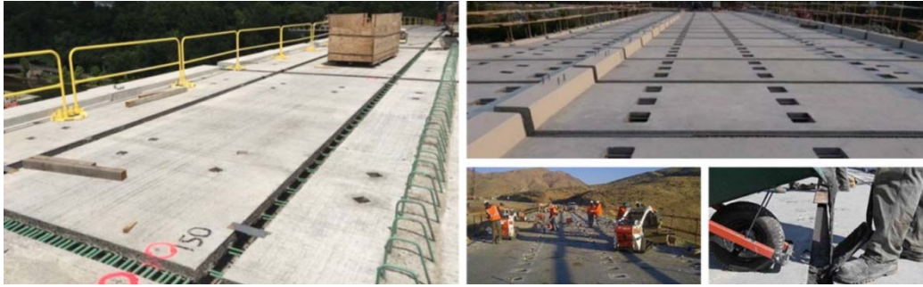
Рис. 3. Применение СПБФ при омоноличивании пролётных строений
