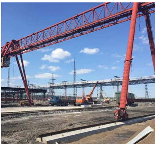
Рис. 1. Обустройство подкранового пути на рабочей площадке козлового крана
